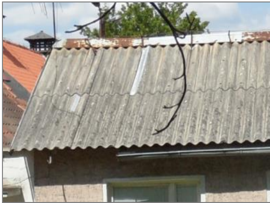
Fot.1 Płyty azbestowo-cementowe faliste płaskie
